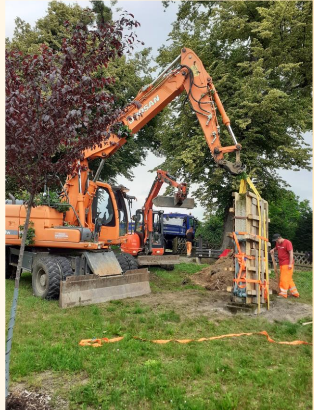
Standsicherheit durch Betonfundament
